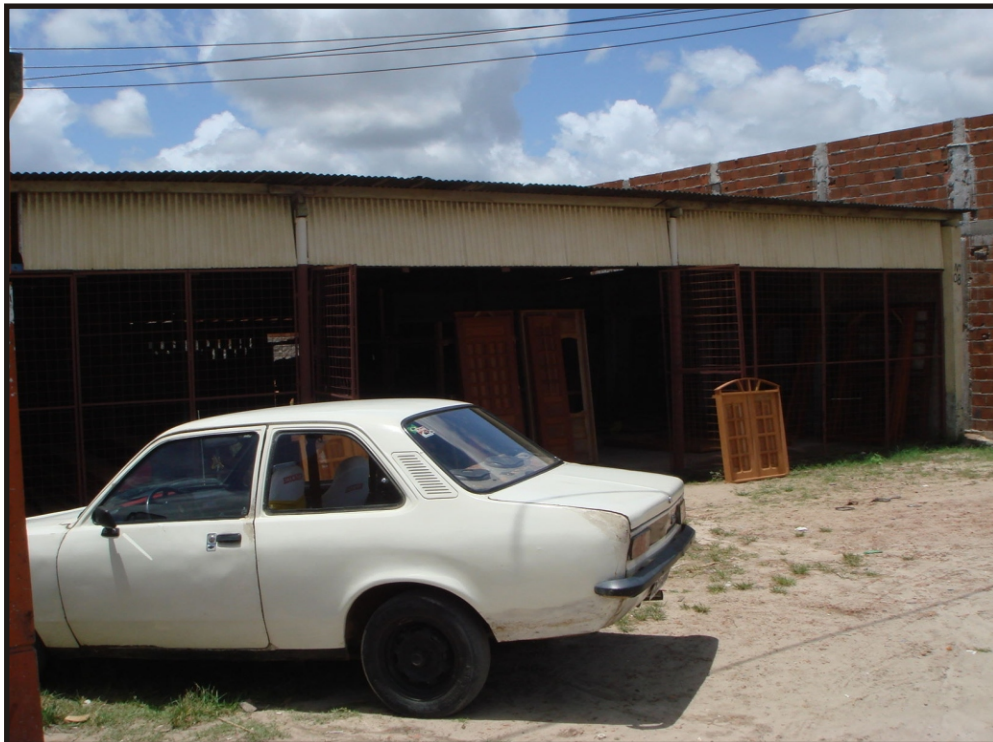
CADASTRO Nº : 006 - BARBOSA IMÓVEL COMERCIAL: SERRARIA ENDEREÇO: ROD. PE-060, KM 1, VILA DA COHAB, CABO
