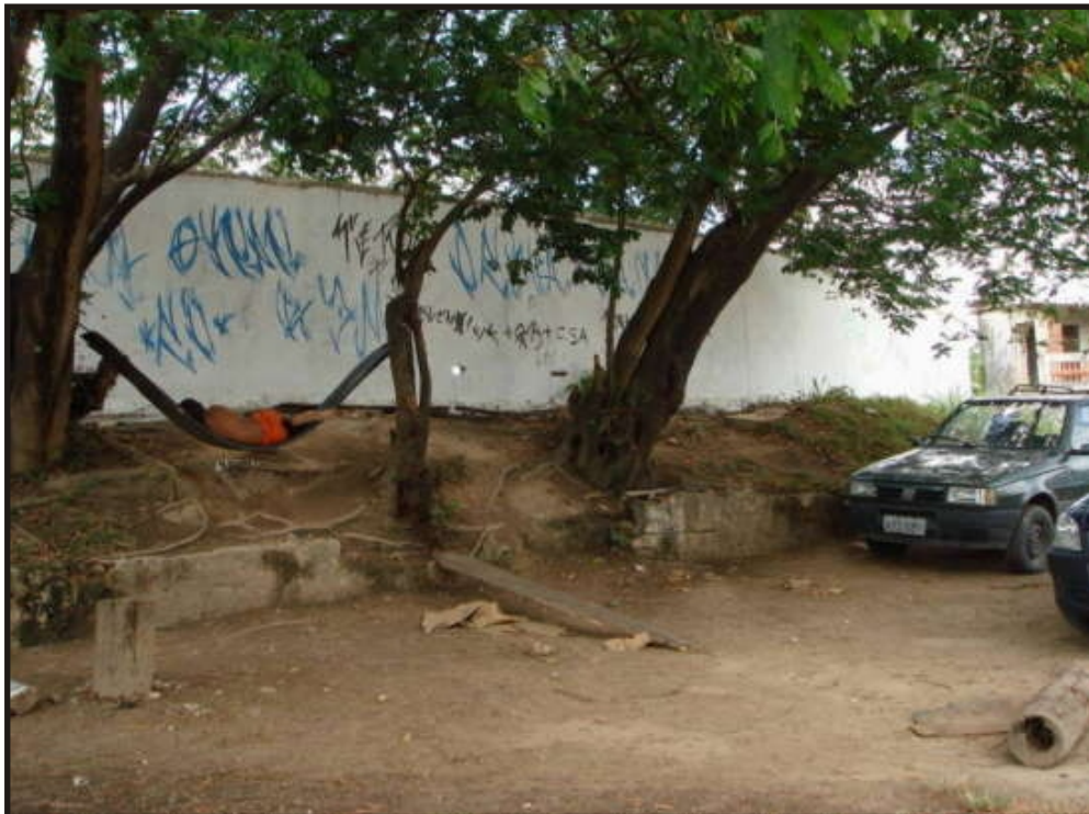
CADASTRO Nº : 012 - COMPESA ( LAGOA DE ESTABILIZAÇÃO ) MURO DE ALVENARIA ENDEREÇO: ROD. PE-060, KM 2, VILA DA COHAB, CABO
