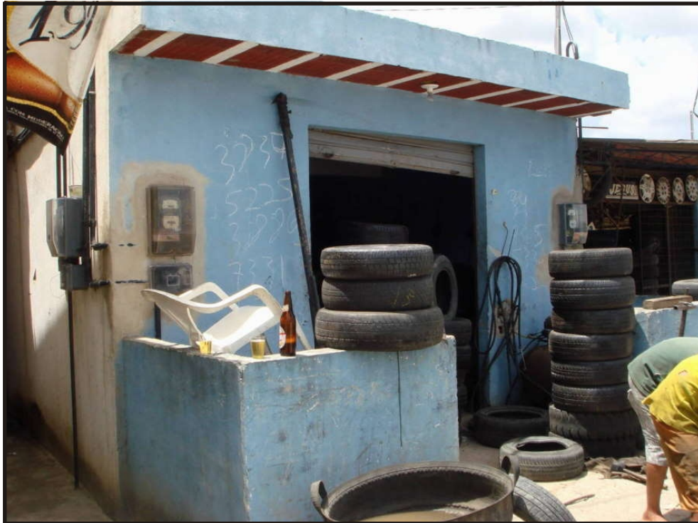
CADASTRO Nº : 009 - FELIPE LUIZ DE MOURA RODRIGUES IMÓVEL COMERCIAL: BORRACHARIA ENDEREÇO:RODOVIA PE-060, KM 2, S/N, VILA DA COHAB, CABO
