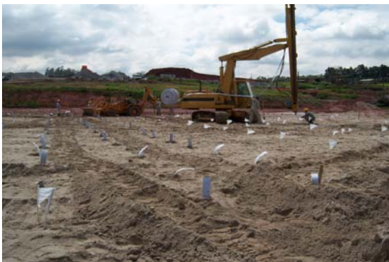
Figura 3.1 - Cravação da malha de drenos verticais
