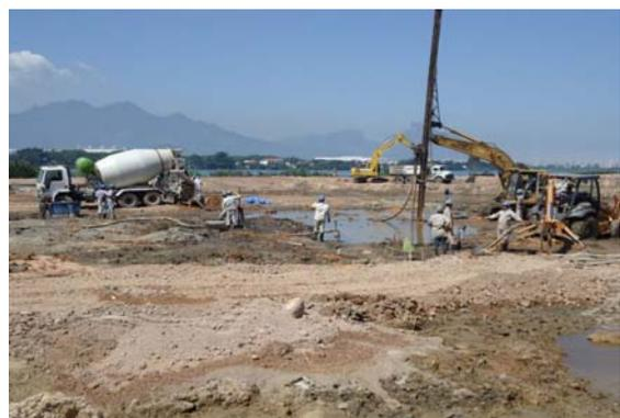
Figura 3.2 Formação das Colunas de Adensamento entre a malha de geodrenos
