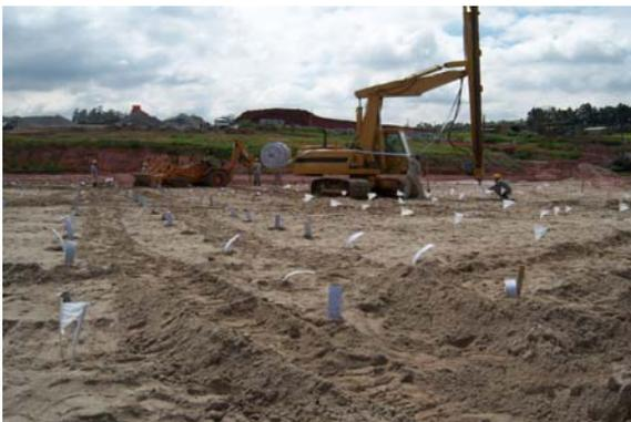
Figura 3.1 - Cravação da malha de drenos verticais
