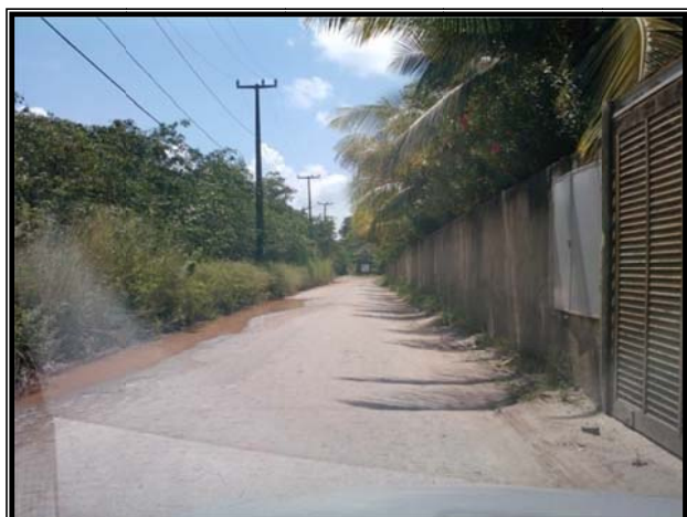
Foto 02 – Trecho pavimentado em paralelo
