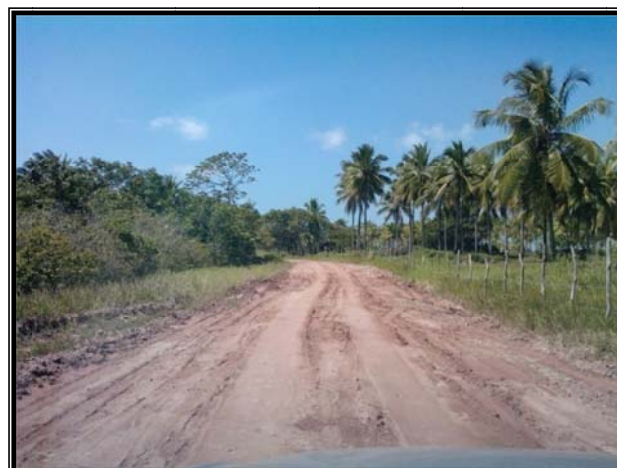
Foto 03 – Estrada carroçavel existente
