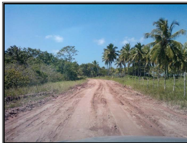
Foto 03 – Estrada carroçavel existente
