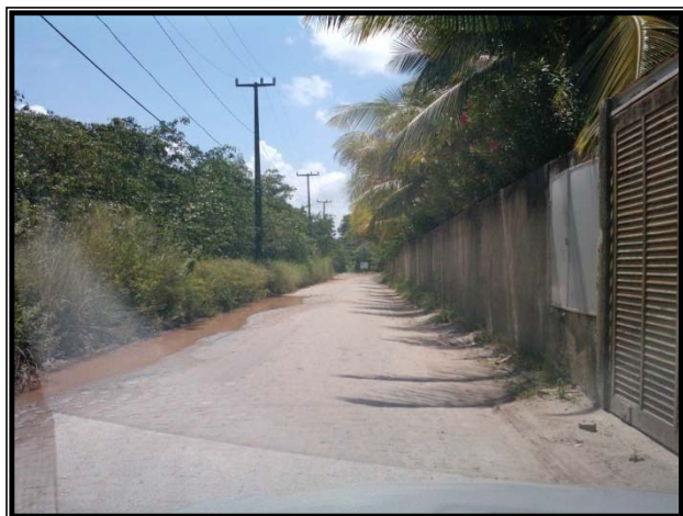
Foto 02 – Trecho pavimentado em paralelo
