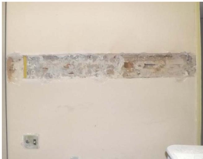
Foto 5 – Foto da prospecção arquitetônica 3 na parede
