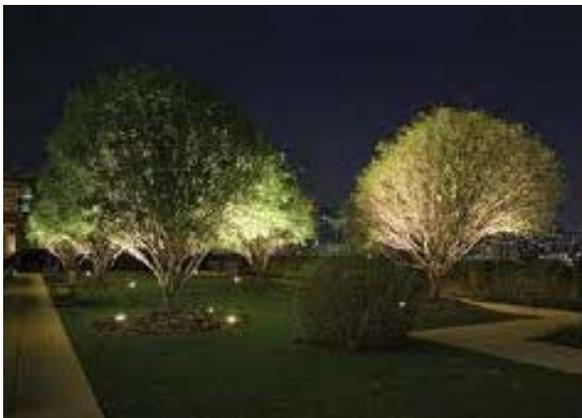
**Figura 4 - Exemplo de instalação dos embutidos de solo**
