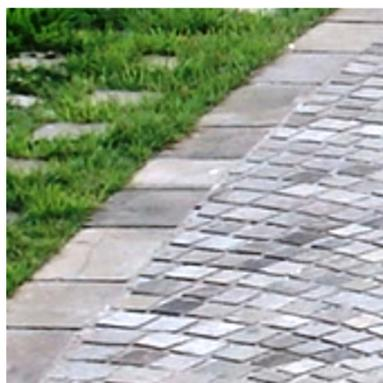
Encabeiramento em Pedra natural tipo quartzito tropical, em blocos medindo 20 x 20 x 4cm, Fabricante Pasinato ou equivalente técnico
